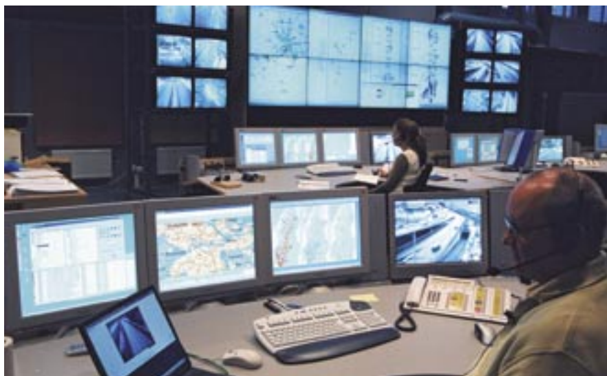
Centrala monitoringu Szwedzkiej Dyrekcji Dróg Krajowych w Sztokholmie
